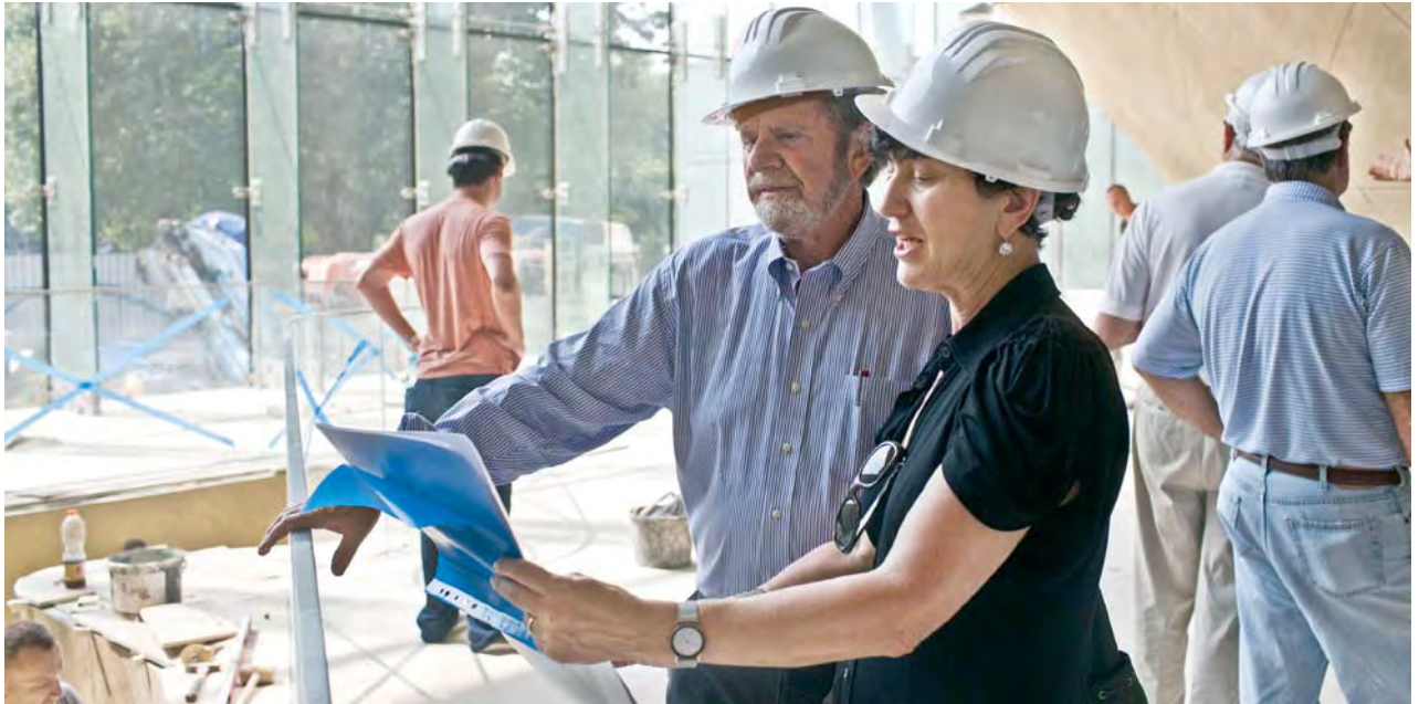
2012: Tad Taube et Shana Penn examinent des plans d'architecte à l'intérieur du Musée de l'histoire des Juifs polonais POLIN lors des travaux de construction.
